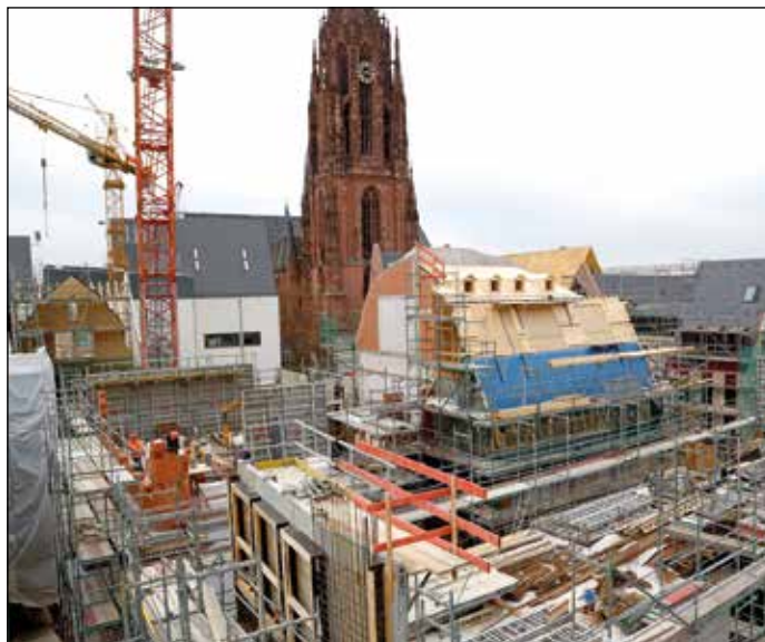
Teilweise sind die Dachaufbauarbeiten in vollem Gange
