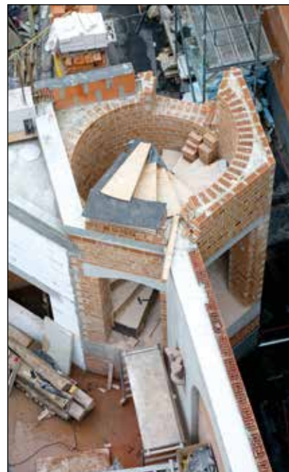
Treppenturm Klein Nürnberg
