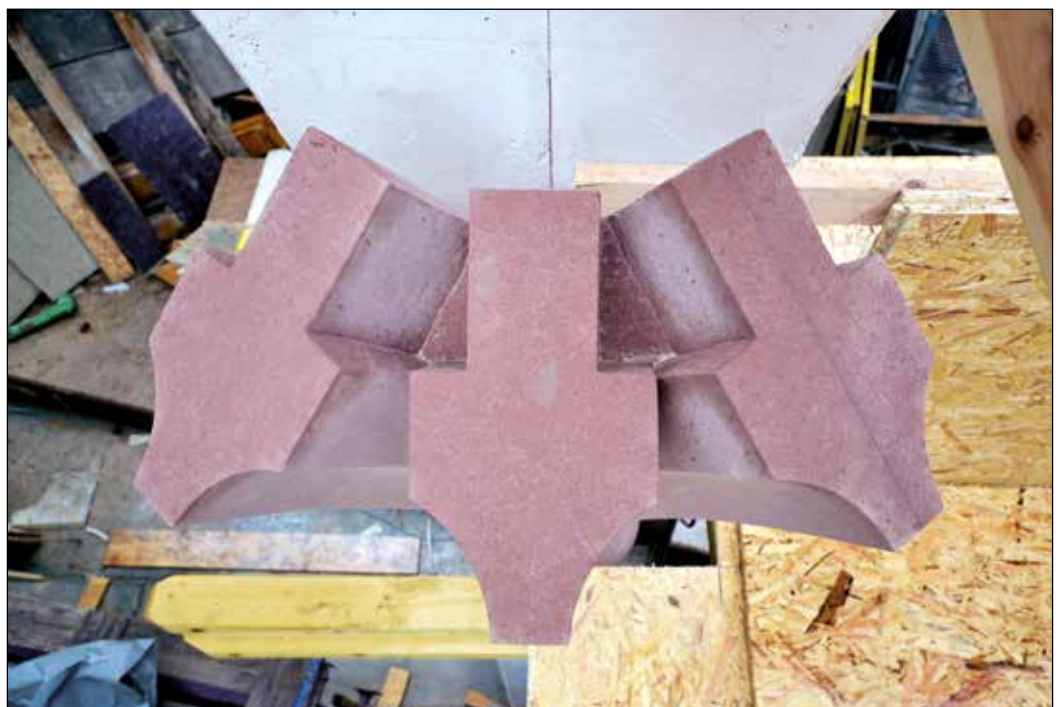
Bereits eingebauter Rippenanfang
