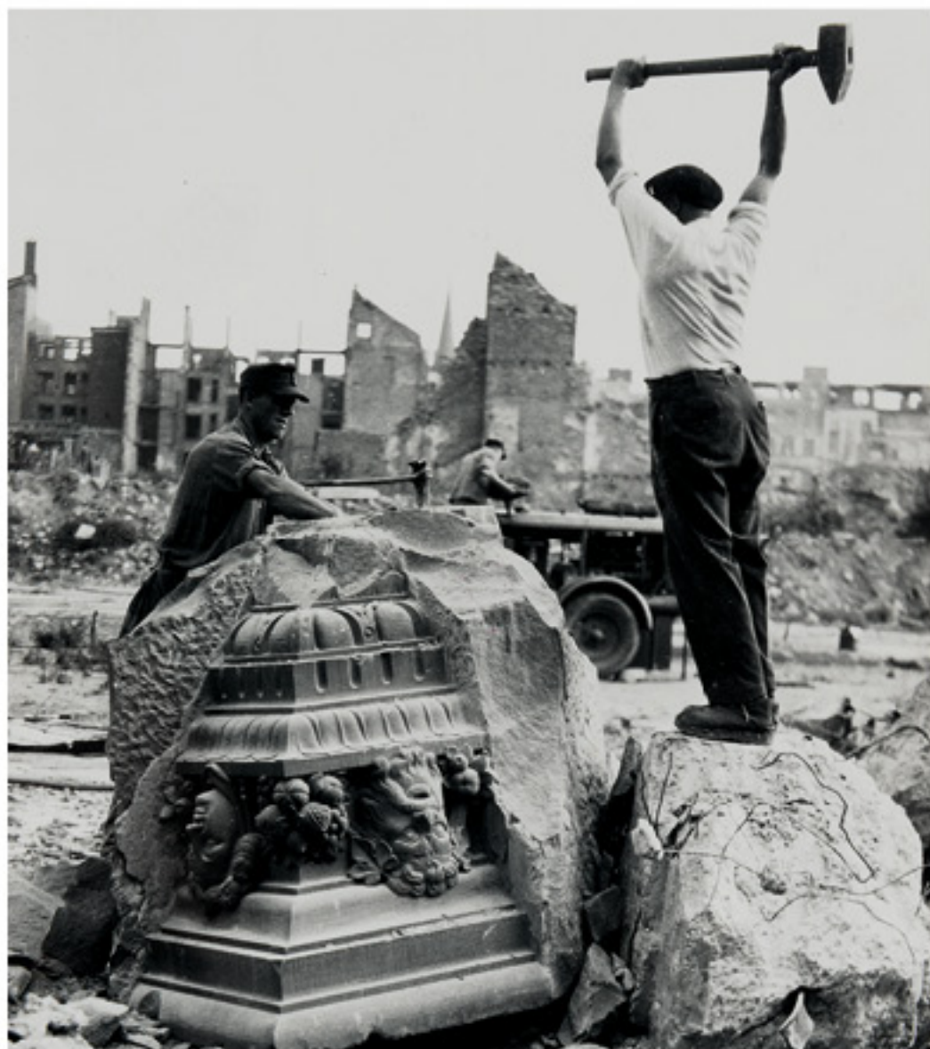
„Entsorgung“ der Bauteile (Braubach-/Domstraße), 15. Juni 1949
