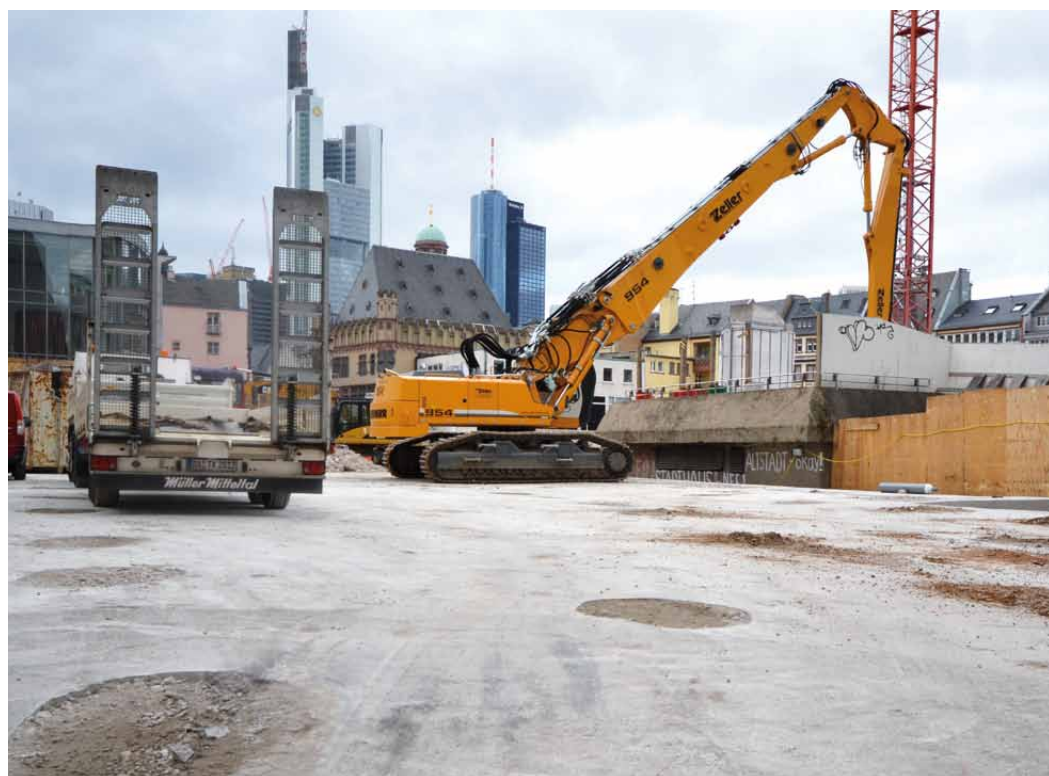
Die Betondecke über dem Archäologischen Garten
