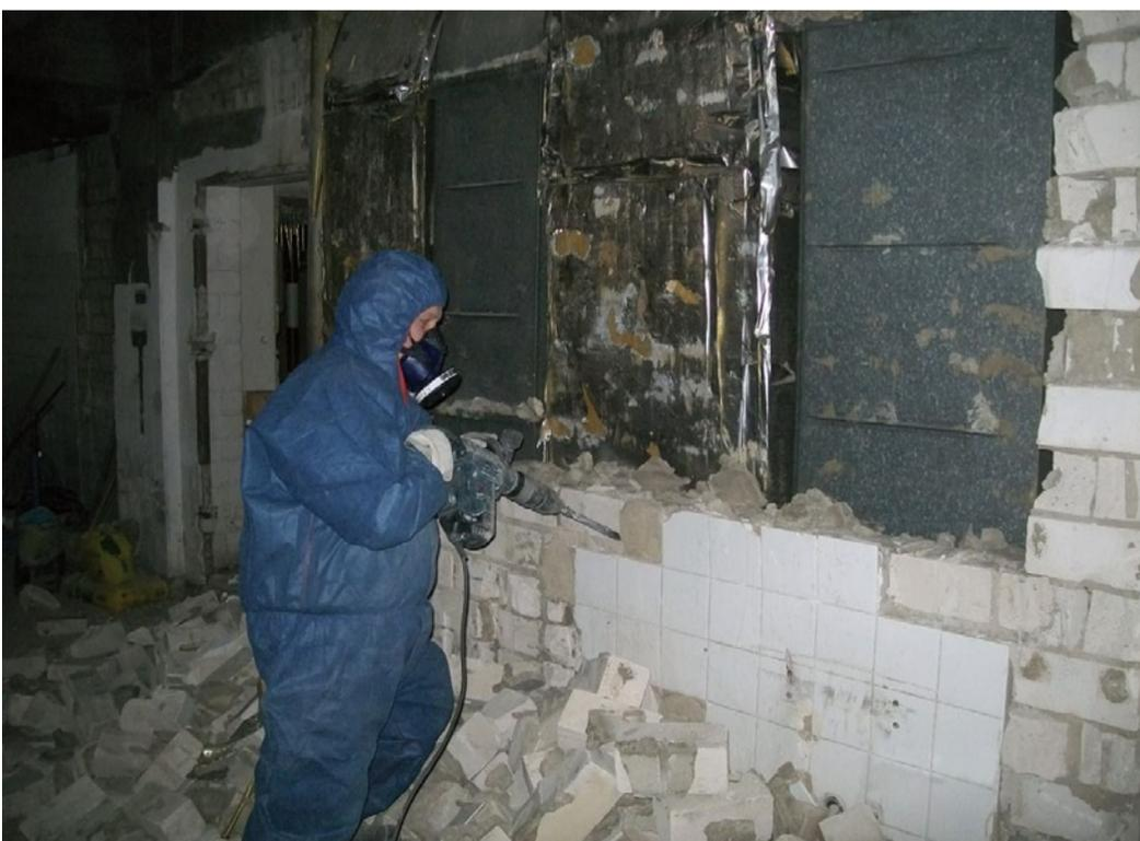
Haustechnik der Tiefgarage wird unterirdisch entfernt, zerlegt und für den Abtransport getrennt
