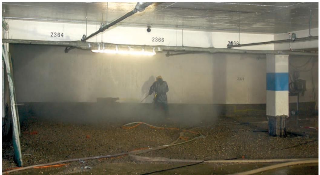
Betonanierung mit Höchstdruck-Wasserstrahltechnik
