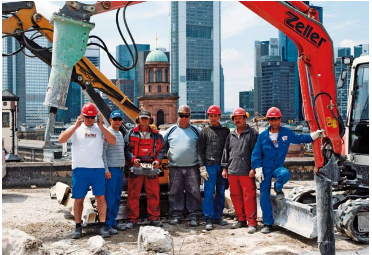
Abbrucharbeiten mit Skylineblick durch das Team von Müssman und Zeller
