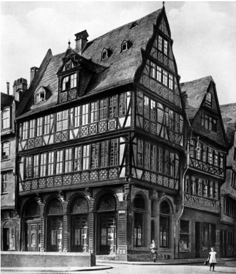
Äußerlich war die Goldene Waage auf den ersten Blick ein typisches Renaissancegebäude der Frankfurter Altstadt: Ein hoher Sockel aus rotem Sandstein zeigte nach außen filigrane, reich verzierte Arkaden – vier auf der zur Höllgasse gewandten Seite, zwei zum Markt hin
