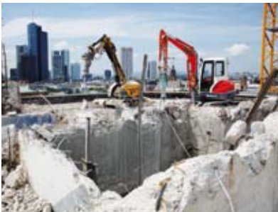
Die Erschließungskerne werden zerlegt
