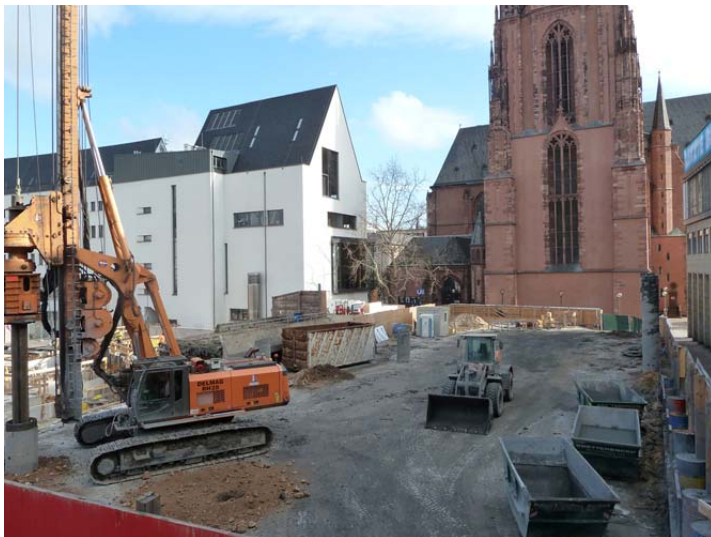
Bildunterschrift 2: Das DomRömer-Quartier wächst nach oben: Die letzten beiden Gründungspfähle für Stadthaus und südliche Häuserzeile am Markt werden gesetzt. (Bildquelle: DomRömer GmbH)
