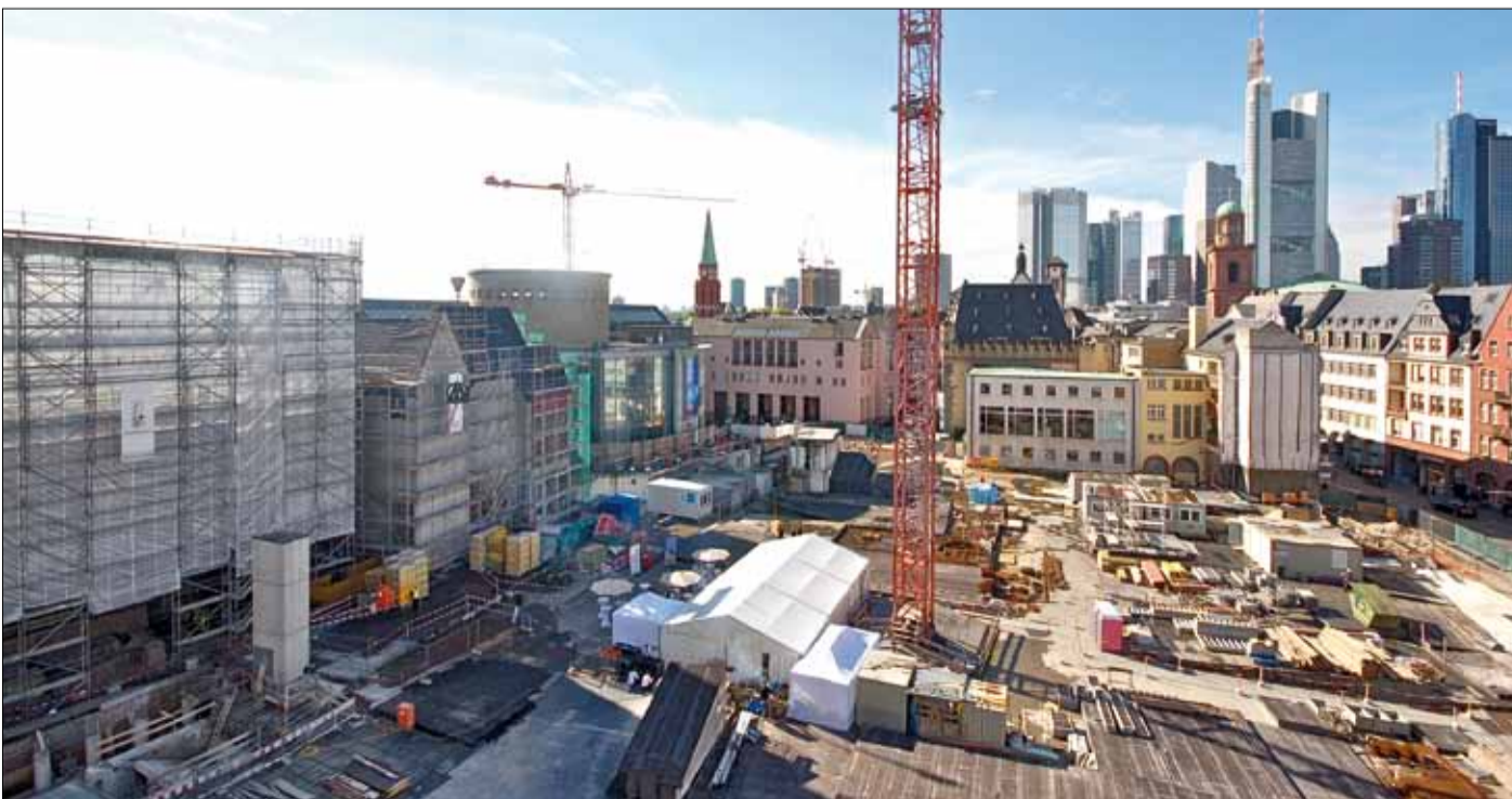
Baufeld für die Altstadthäuser, links das eingerüstete Stadthaus
