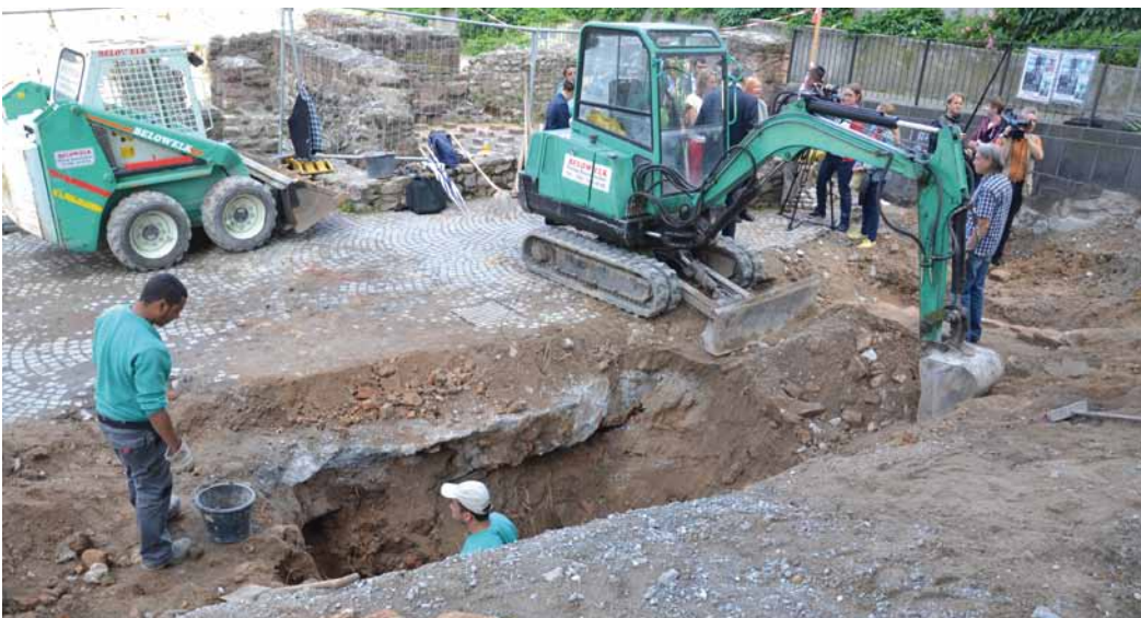
Mit leichtem Gerät wird im Bereich der Treppe gegraben
